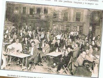
Un detalle de la amplia terraza del «Café-Lechería Bibarrambla», ocupada totalmente por el público.
